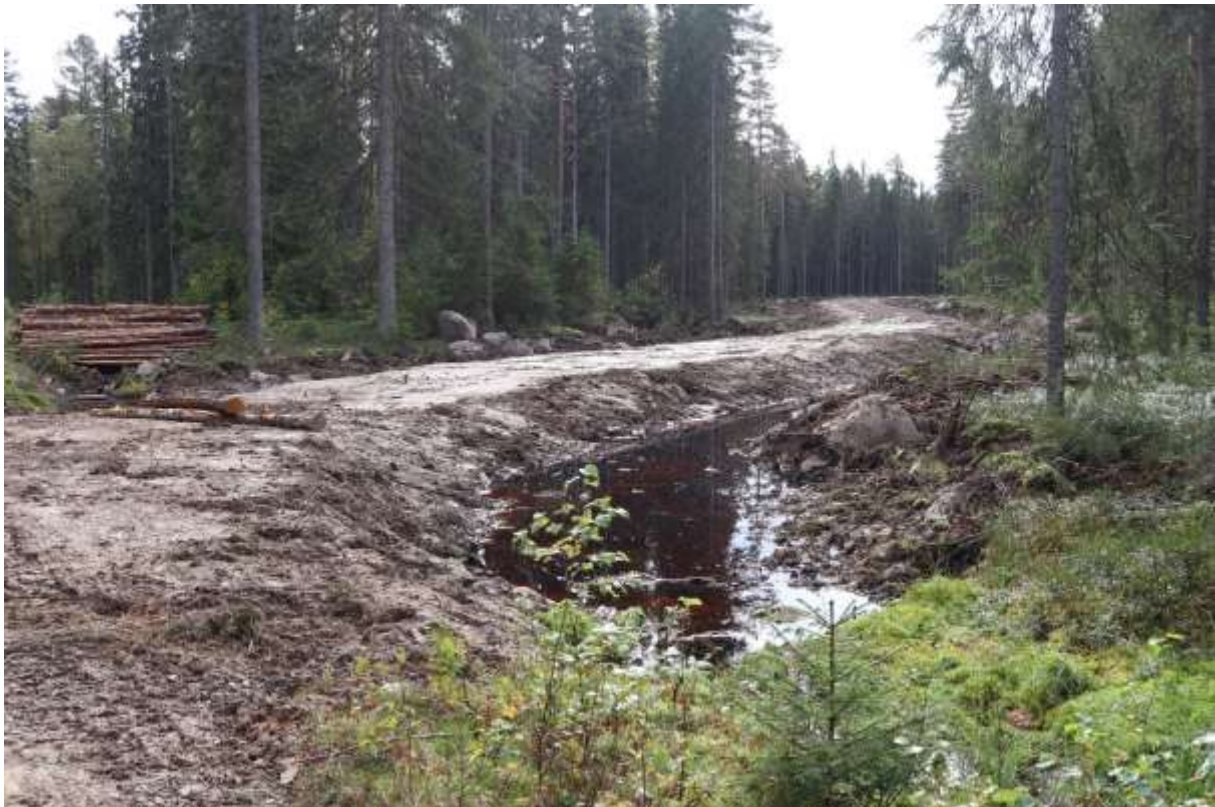
Figur 1: Byggandet av skogsbilvägen har förstört hydrologin och uttraderat naturvärden i form av många gamla träd.
