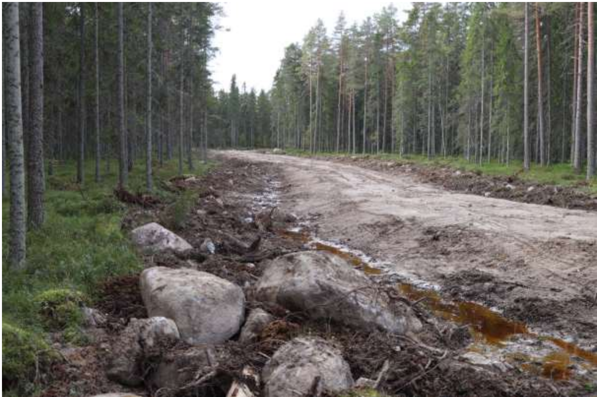
Figur 3: Vägbygget har medfört en dränering av naturskogen. När den humusrika jorden friläggs och vattenspegeln sjunker ökar ämnesomsättningen i jorden och stora mängder klimatskadlig koldioxid frigörs.
